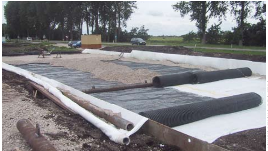
Aanleg van de granulaatmatras op palen.
